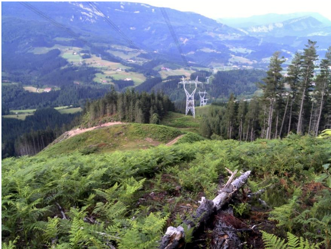
Fotografía: Torres de tensión presentes en Oñati. Fuente: Google Earth
